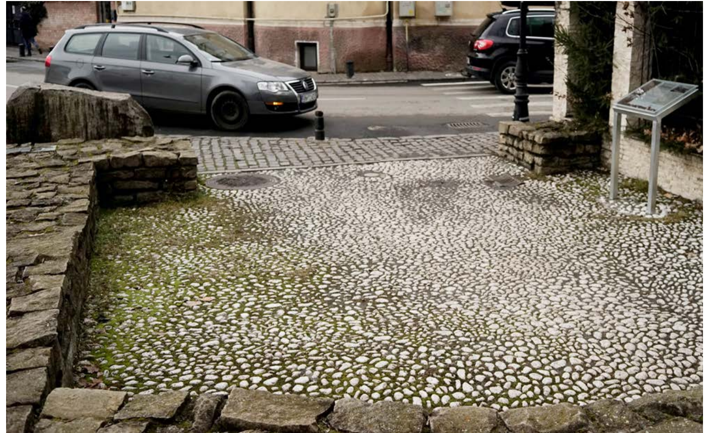
Turnul Rotarilor – fundația vizibilă în strada Ecaterina Teodoriu, marcată și prin textură diferențiată a pavajului (pietre albe)
