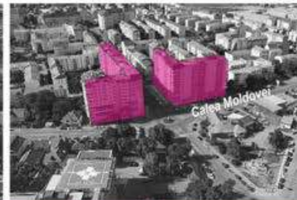
locuire colectivă, P+7
