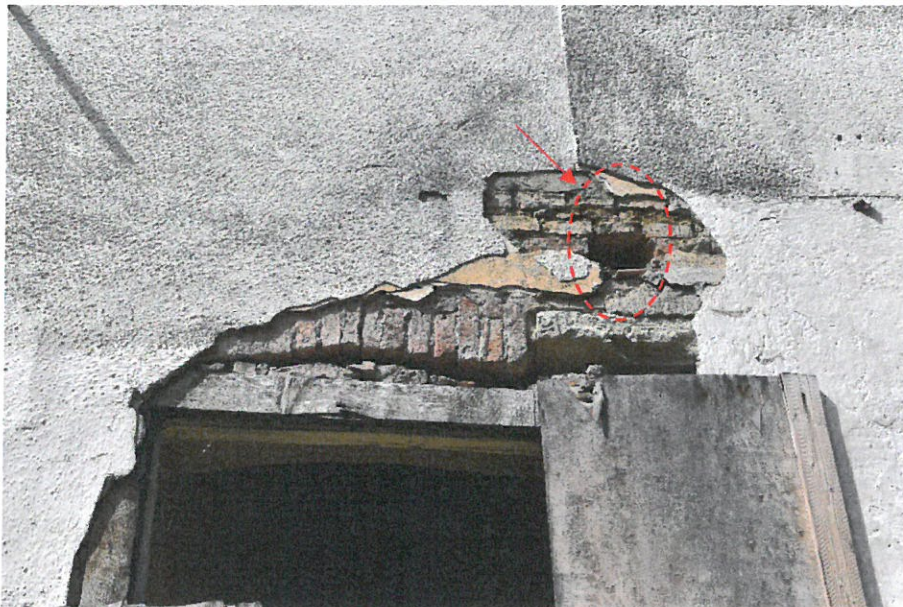
Foto nr. 19 – Dislocări ale elementelor de tencuială și finisaj la nivelul pereților exteriori, degradări ale elementelor de zidărie, prezența unor goluri în zidărie
