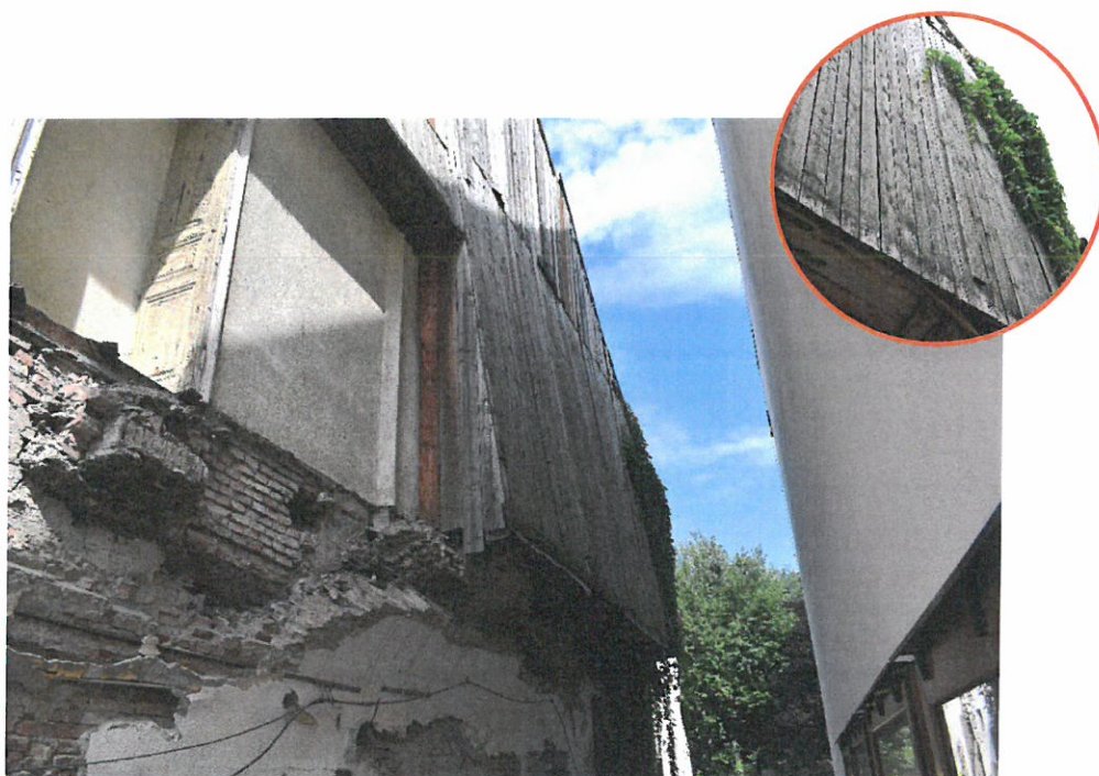
Foto nr. 14 – Închideri realizate cu caracter de improvizație
