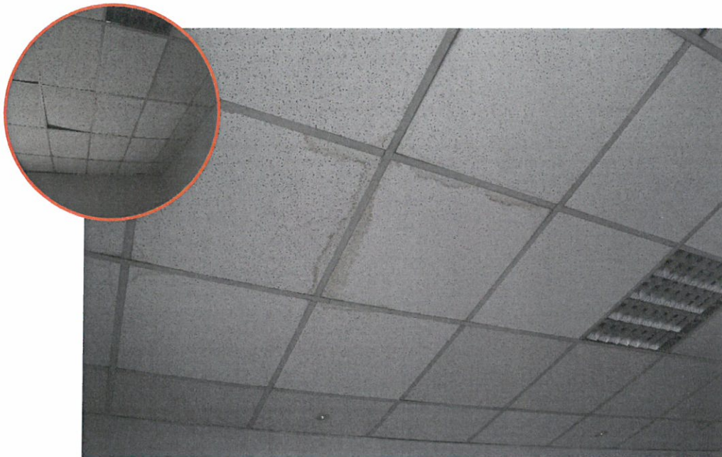
Foto nr. 61 – Degradări la nivelul tavanului cauzate de infiltrațiile locale de apă, desprinderi locale ale elementelor de placaj
