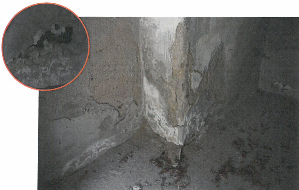
Foto nr. 31 – Degradări avansate ale elementelor de tencuială și finisaj de la baza pereților interiori cauzate de infiltrațiile locale de apă
