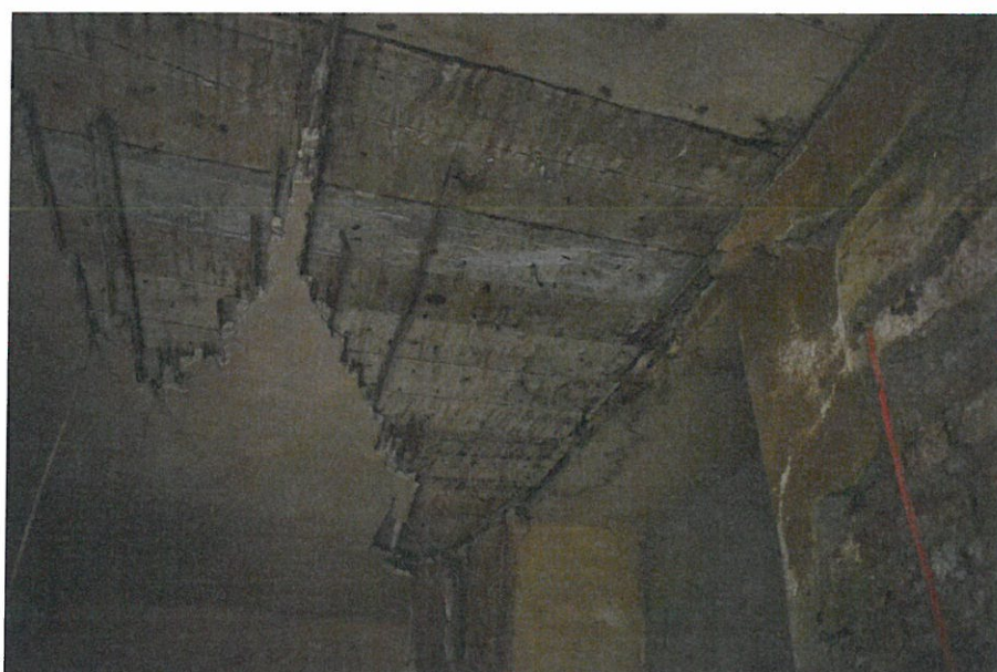
Foto nr. 44 – Degradări semnificative la intradosul tavanului - degradări la nivelul materialului lemnos din alcătuirea planșeului de pod, dislocări ale elementelor de tencuială și finisaj
