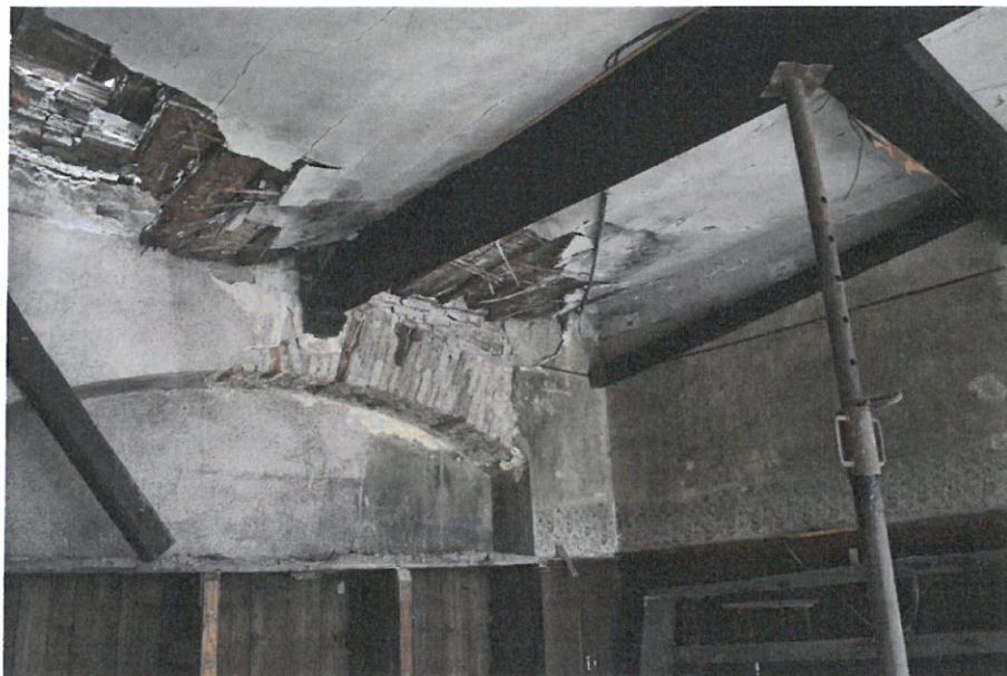
Foto nr. 47 – Degradări semnificative la nivelul tavanului – desprinderi ale elementelor de tencuială și finisaj cauzate de infiltrațiile accentuate de apă, sprijiniri realizate cu caracter de improvizație
