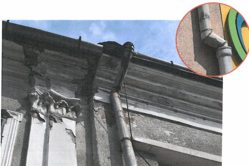
Foto nr. 9 – Degradări la nivelul sistemului de colectare și evacuare a apelor pluviale – prezența fenomenului de coroziune la nivelul jgheabului și burlanului metalic; degradări și desprinderi ale elementelor arhitecturale
