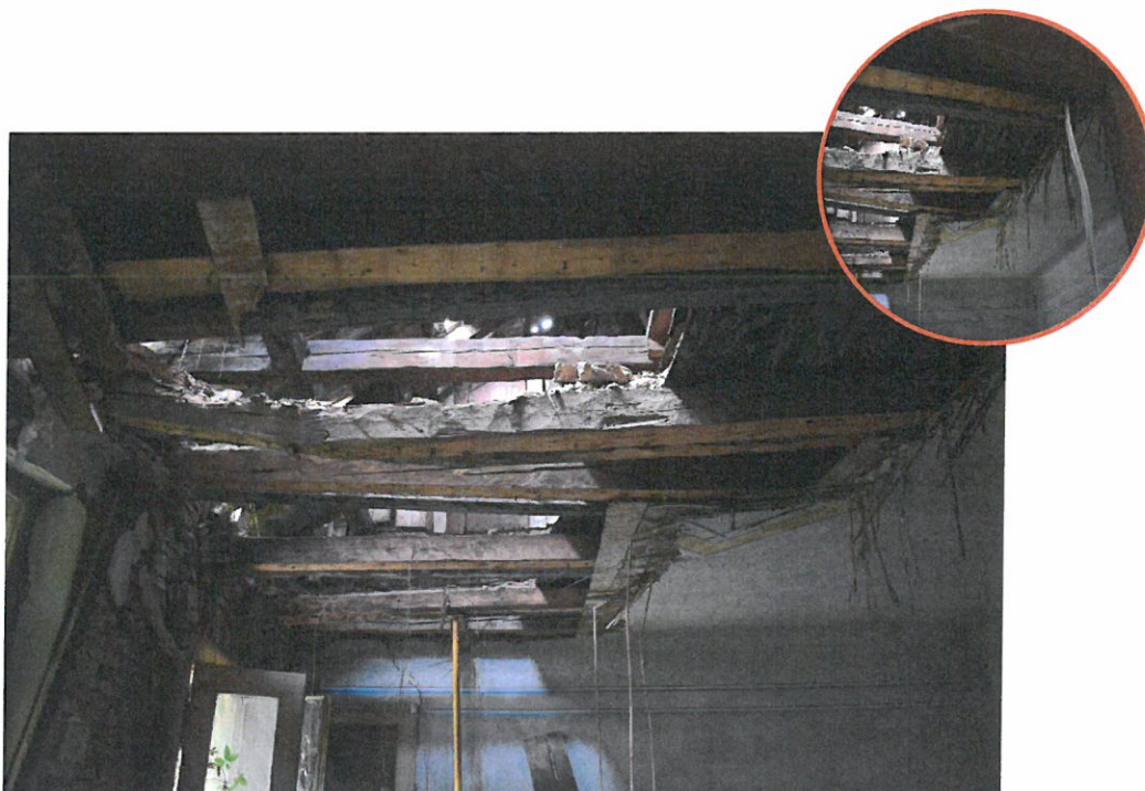
Foto nr. 48 – Degradări avansate la nivelul planșeului de pod – desprinderea elementelor componente, elemente structurale susceptibile la pierderea stabilității, sprijiniri realizate cu caracter de improvizație
