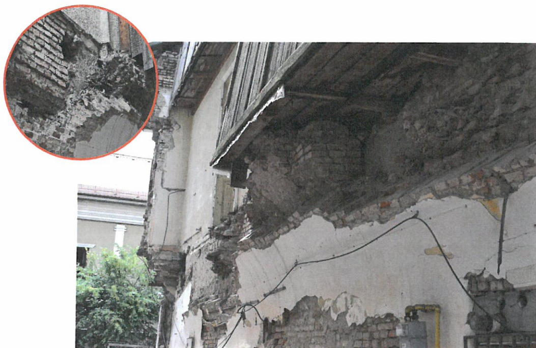
Foto nr. 11 – Lucrări de demolare nefinalizate; Proeminențe ale elementelor de planșeu susceptibile la pierderea stabilității
