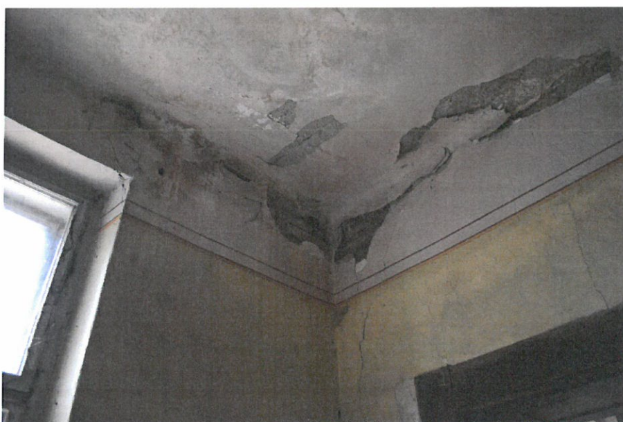
Foto nr. 38 – Desprinderi ale elementelor de tencuială și finisaj, fisuri în cadrul pereților interiori
