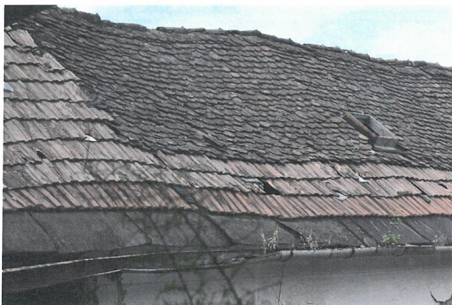
Foto nr. 28 – Degradări la nivelul învelitorii – ciobiri ale elementelor componente, elemente deteriorate de acțiunea factorilor meteorici; prezența mai multor tipuri de elemente de învelitoare
