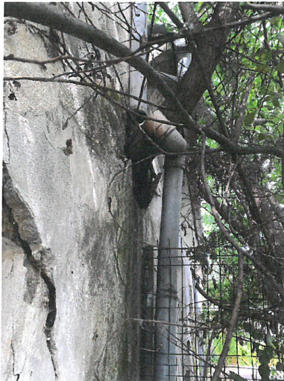
Foto nr. 23 – Dezvoltarea vegetației în interiorul clădirii – străpungerea peretelui de către trunchiul copacului
