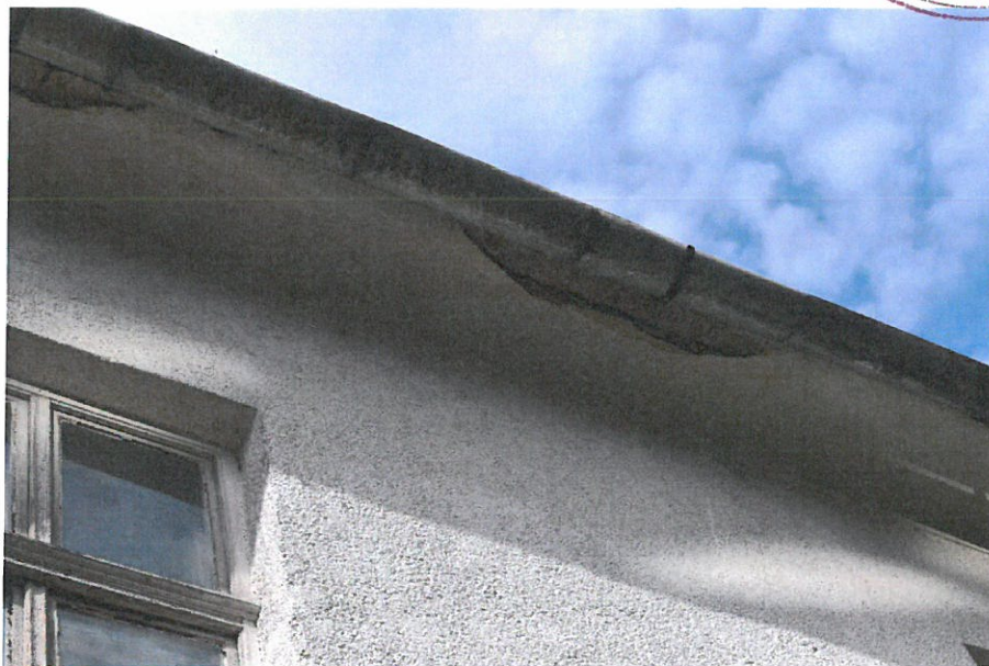
Foto nr. 22 – Dislocări ale elementelor de tencuială și finisaj de la nivelul paziei, prezența coroziunii la nivelul jgheabului
