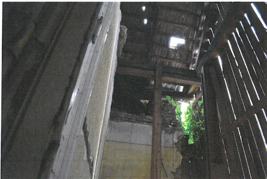
Foto nr. 55 – Degradări avansate ale elementelor de șarpantă - lipsa etanșeității la nivelul învelitorii, dezvoltarea vegetației în interiorul construcției
