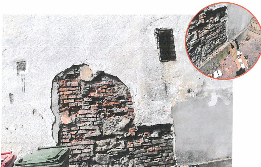
Foto nr. 20 – Degradarea avansată a elementelor de zidărie – macerarea cărămidzilor cauzată de acțiunea factorilor meteorici și de lipsa finisajelor
