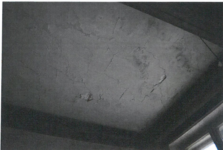
Foto nr. 43 – Fisuri cu traseu dispers în cadrul tavanului cauzate de infiltrațiile de apă
