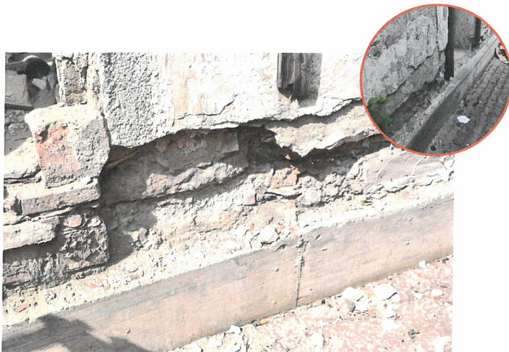
Foto nr. 17 – Degradări avansate la baza pereților exteriori – dislocări ale elementelor de tencuială și finisaj, ciobiri ale cărămizilor
