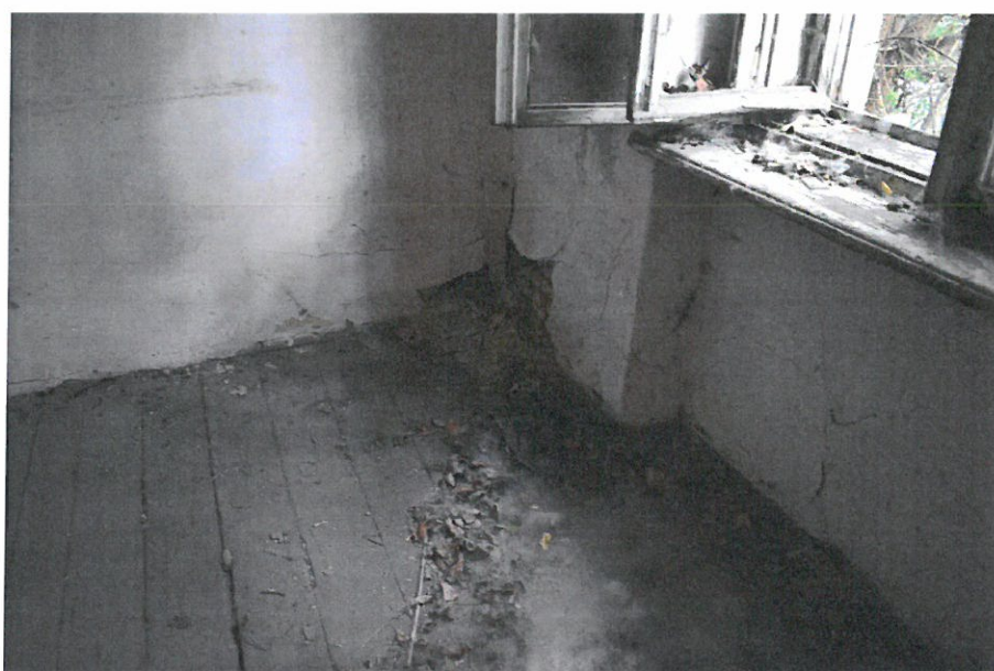
Foto nr. 32 – Degradări la baza pereților interiori - dislocări ale elementelor de tencuială și finisaj, prezența fisurilor, dezvoltarea mușcăiului la nivelul materialului lemnos din pardoseli
