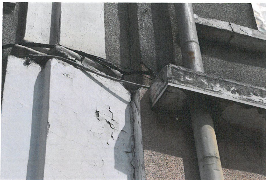
Foto nr. 7 – Degradări la nivelul peretelui exterior – dislocări și exfolieri locale ale elementelor de tencuială și finisaj, trasee de instalații realizate neconform
