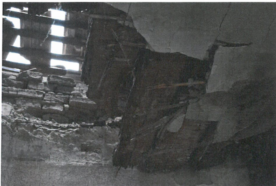
Foto nr. 53 – Degradări avansate ale elementelor de șarpantă, lipsa etanșeității la nivelul învelitorii
