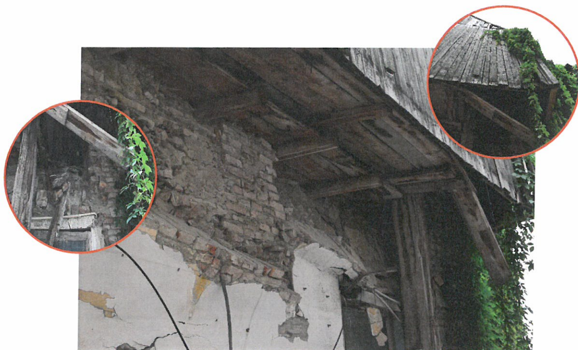
Foto nr. 15 – Degradări avansate ale elementelor structurale – lipsa lucrărilor de corectare a deficiențelor cauzate de demolarea realizată și accentuarea și cedarea elementelor sub acțiunea factorilor meteorici
