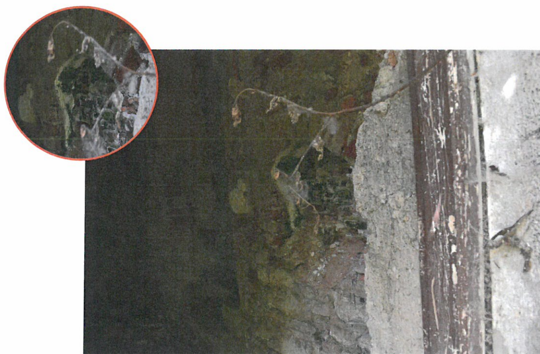
Foto nr. 40 – Degradări avansate la nivelul elementelor de zidărie – macerări ale cărămidzilor, dezvoltarea mucegaiului pe suprafața acestora
