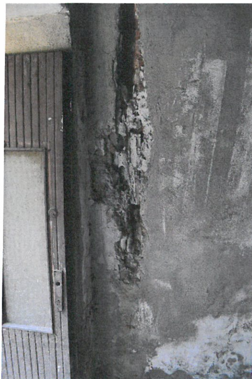
Foto nr. 39 – Degradări avansate la nivelul pereților interiori – degradări ale elementelor de zidărie, dislocări ale elementelor de tencuială și finisaj
