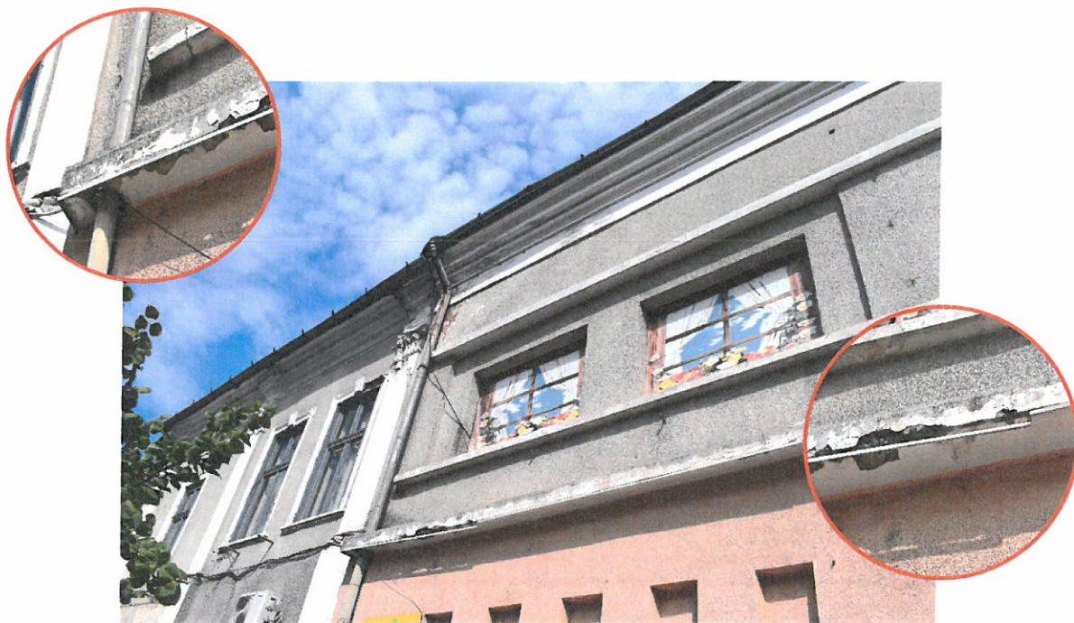
Foto nr. 6 – Degradări la nivelul peretelui exterior – dislocări ale elementelor de tencuială și finisaj
