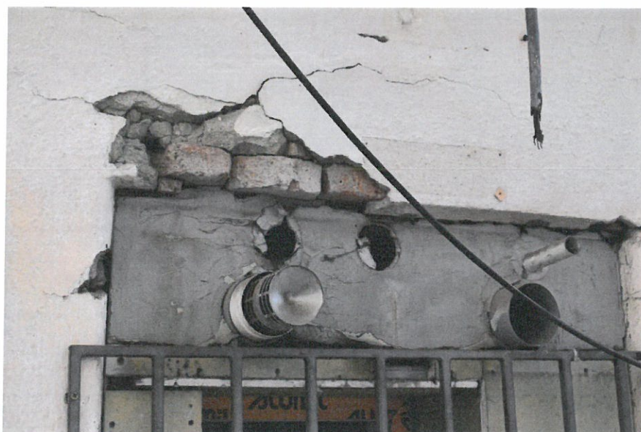
Foto nr. 26 – Trasee de instalații realizate neconform
