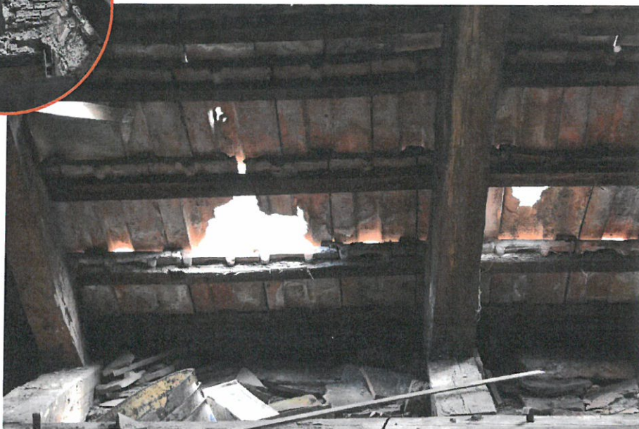
Foto nr. 57 – Degradări avansate ale elementelor de șarpantă - lipsa etanșeității la nivelul învelitorii, elemente afectate de atac de cari și infiltrațiile accentuate de apă
