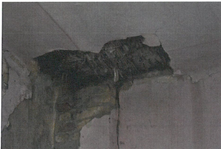
Foto nr. 46 – Degradări semnificative la nivelul tavanului – desprinderi ale elementelor componente, degradări cauzate de infiltrațiile de apă
