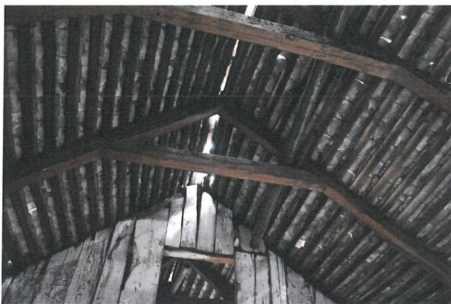
Foto nr. 56 – Degradări ale elementelor de șarpantă cauzate de atacul de cari și infiltrațiile accentuate de apă
