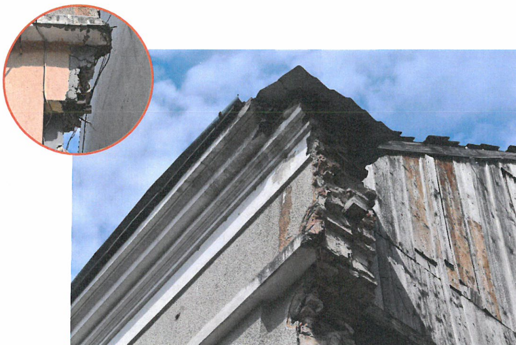
Foto nr. 10 – Lucrări de demolare nefinalizate; Proeminențe ale pereților susceptibile la pierderea stabilității
