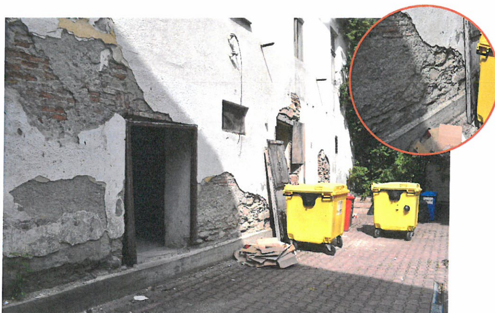
Foto nr. 18 – Degradări la nivelul tencuielilor și finisajelor pereților exteriori – dislocări ale acestora
