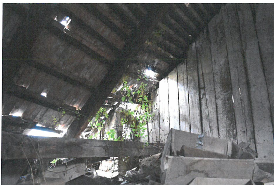
Foto nr. 54 – Degradări avansate ale elementelor de șarpantă - lipsa etanșeității la nivelul învelitorii, dezvoltarea vegetației la nivelul învelitorii
