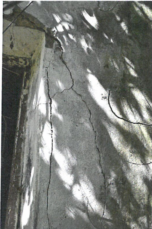
Foto nr. 21 – Fisuri în cadrul pereților exteriori
