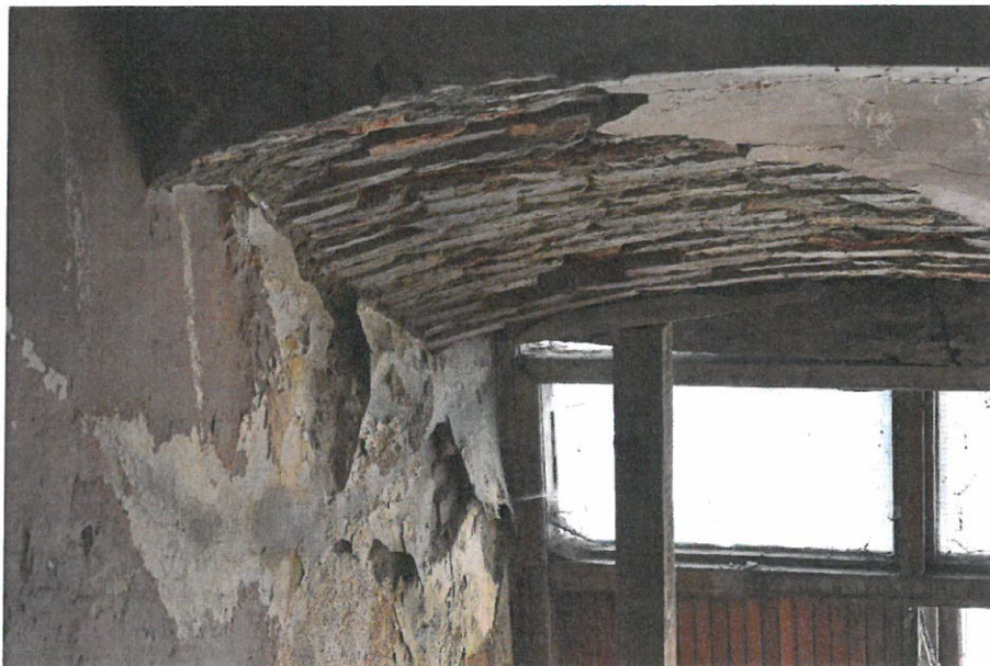
Foto nr. 45 – Desprinderi ale elementelor de tencuială și finisaj de la nivelul pereților și boltii, degradări ale elementelor de zidărie
