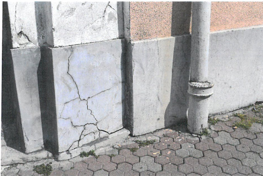
Foto nr. 5 – Degradări la nivelul soclului – fisuri cu traseu dispers
