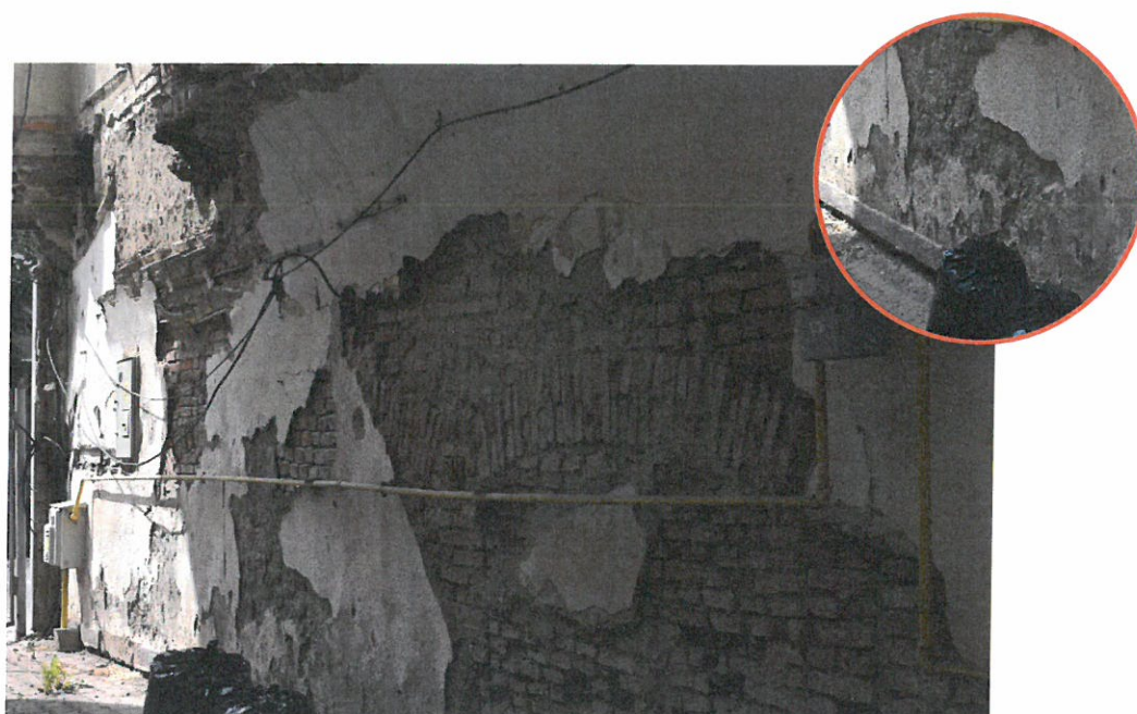
Foto nr. 12 – Degradări avansate ale elementelor de tencuială și finisaj de la nivelul peretelui exterior – dislocări ale acestora
