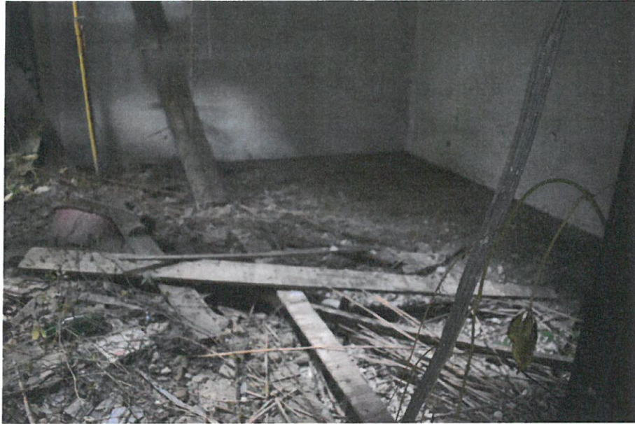
Foto nr. 49 – Cedarea și prăbușirea elementelor din alcătuirea planșeului de pod
