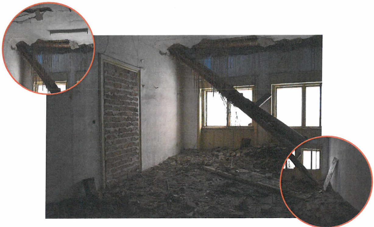
Foto nr. 50 – Umplerea necorespunzătoare a unui gol de ușă, cedarea unei grinzi de planșeu, desprinderi ale elementelor componente de la nivelul tavanului
