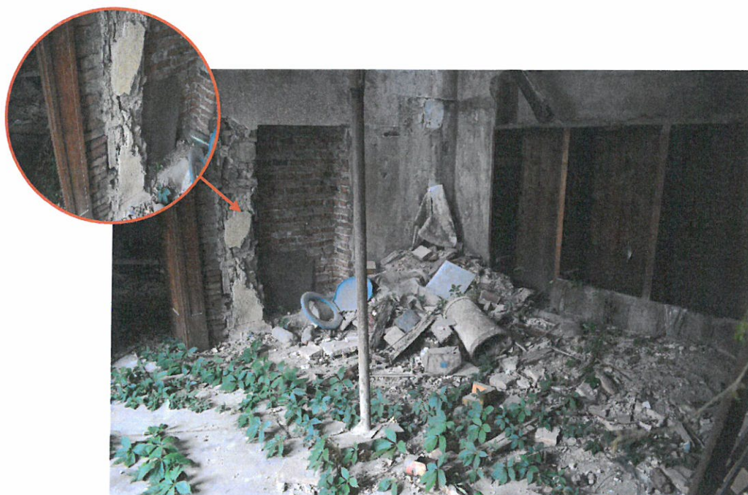
Foto nr. 41 – Degradări avansate la nivelul elementelor de zidărie și tencuială, sprijiniri realizate cu caracter de improvizație, dezvoltarea vegetației în interiorul clădirii
