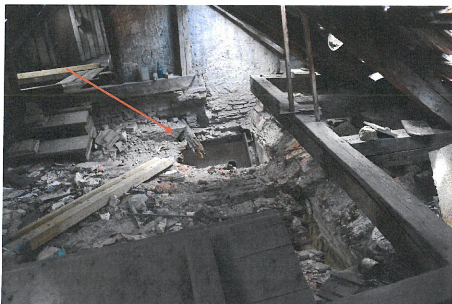
Foto nr. 58 – Degradări avansate la nivelul planșeului de pod – cedarea mecanică a elementelor componente, degradări avansate ale elementelor de zidărie
