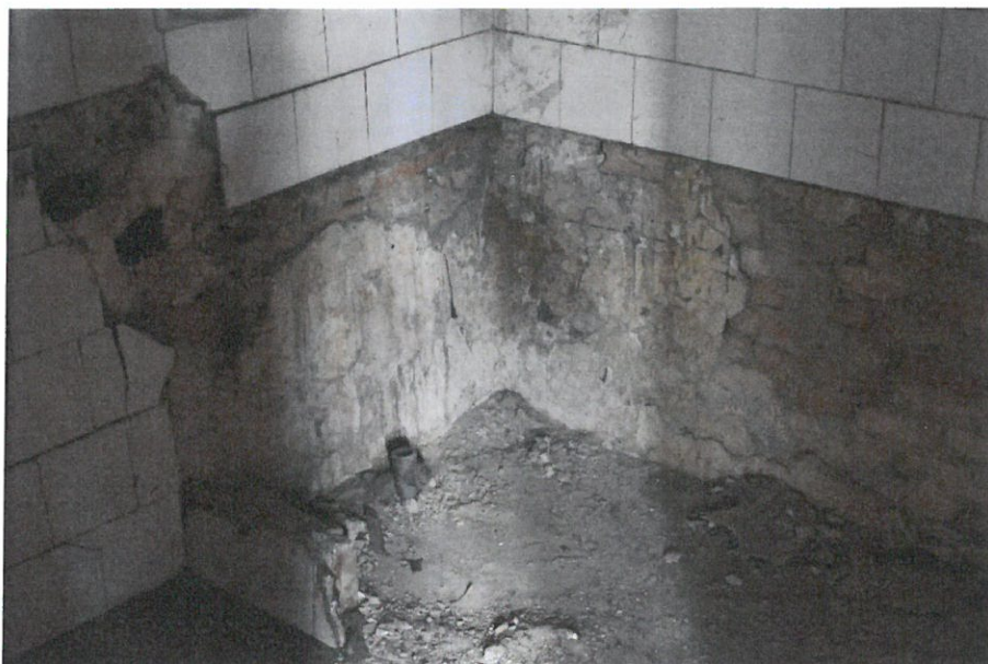
Foto nr. 33 – Degradări la nivelul pereților interiori - dislocări ale elementelor de tencuială și finisaj, degradări ale elementelor de zidărie
