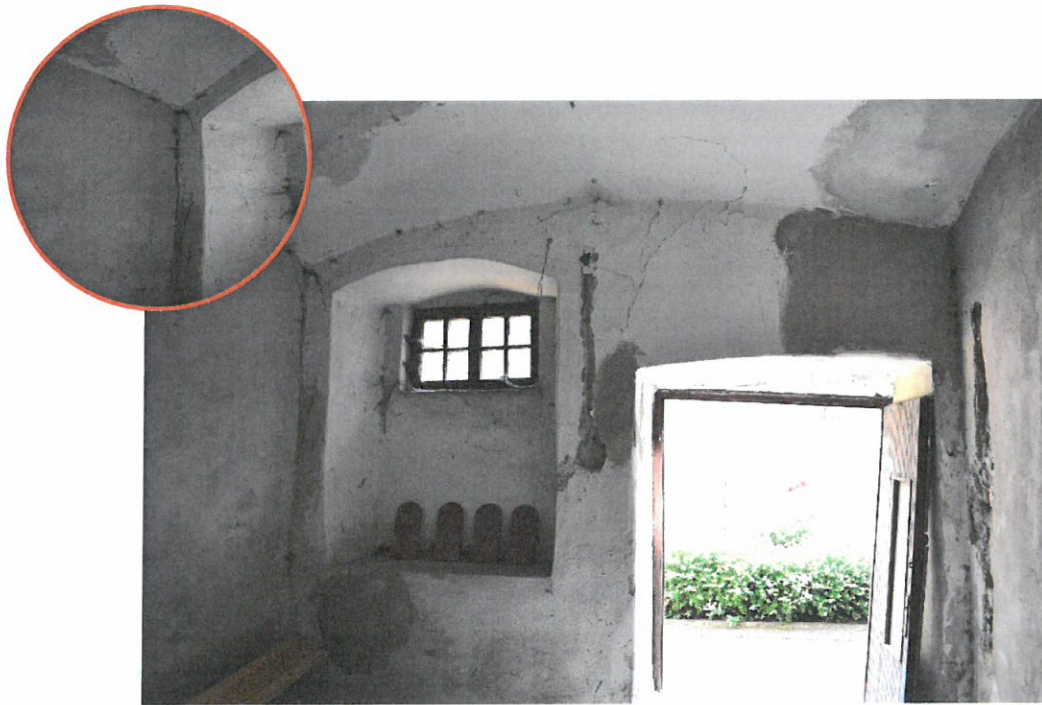
Foto nr. 35 – Aspect general cameră, fisuri în cadrul pereților interiori
