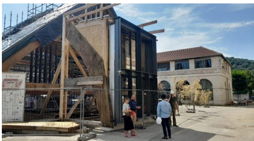
Restaurarea unei vechi cazărmi militare în Besancon, Franța, menținând toate accesoriile în circulație, inclusiv instalații sanitare, rafturi, scaune, accesorii etc.
