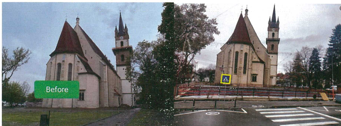
Fig. 3.5. Imagini cu starea initiala a amplasamentului si situatia din momentul depunerii amendamentului
