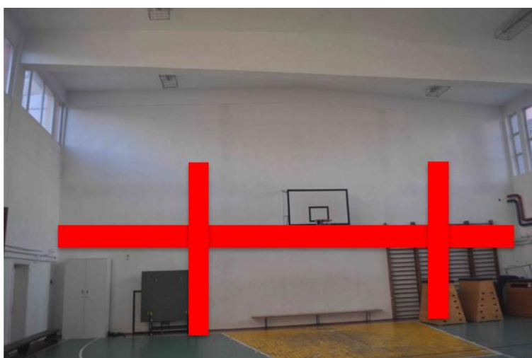
Fig. 8 – Poziționarea scanărilor efectuate în vederea determinării sâmburilor și centurilor de beton armat din frontonul din axul 9
