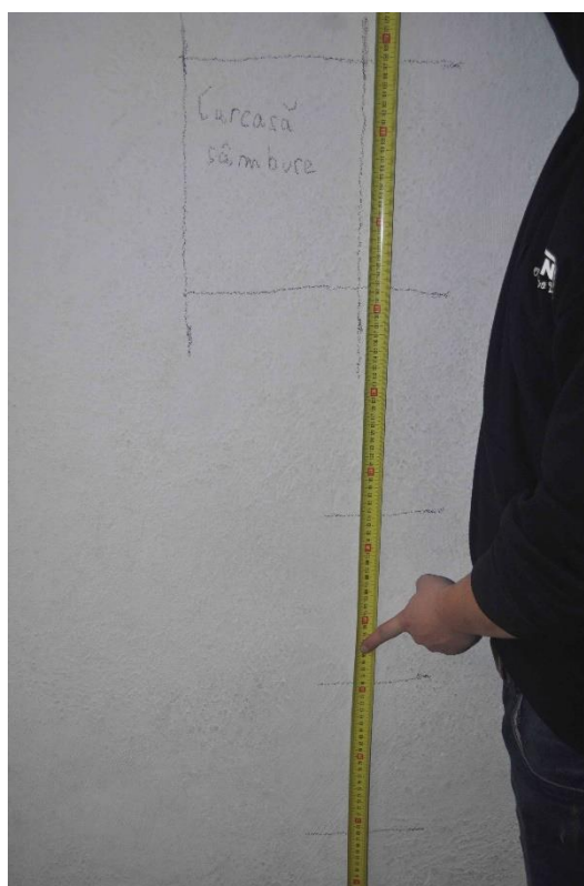
Foto nr. 22 - Dispunere etrieri în sâmbure din ax 9
