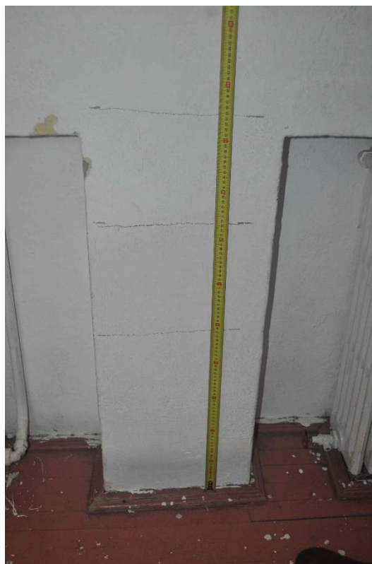
Foto nr. 3 – Dispunere etrieri pe zona critică a stâlpului B/7
