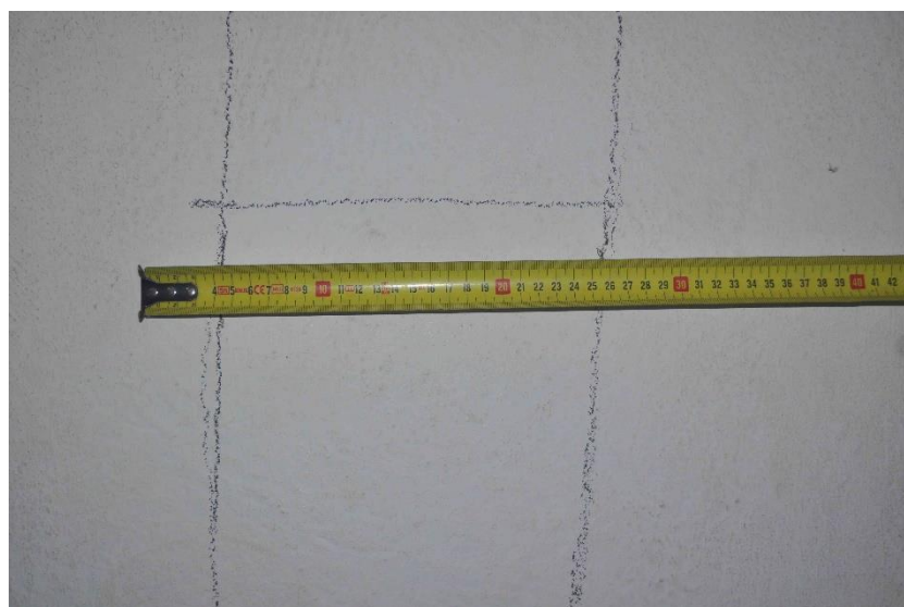
Foto nr. 18 – Carcasă de armătură sâmbure din ax 1
