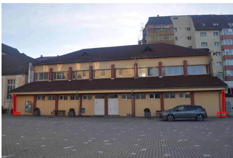
Fig. 30 – Sondaje nedistructive efectuate la nivelul fațadei din axul C în vederea determinării existenței sâmburilor de beton armat din colțurile C/1 și C/9
