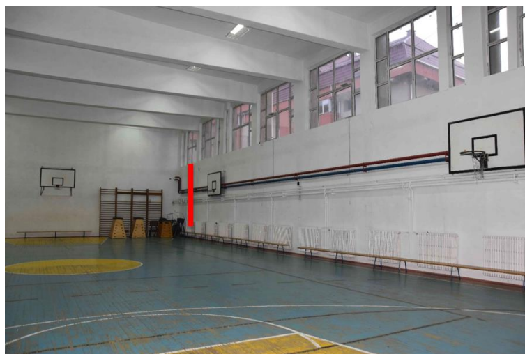
Fig. 20 – Sondaj realizat pe peretele din axul A în vederea determinării existenței centurii de beton armat sub geamuri
