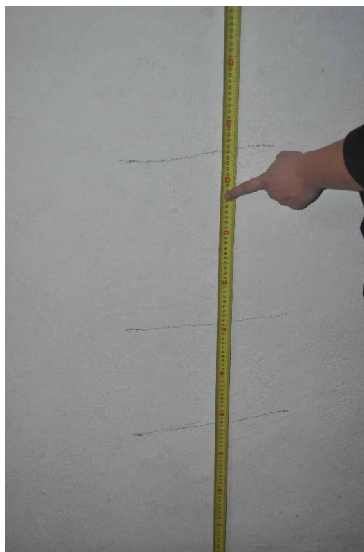
Foto nr. 19 – Dispunere etrieri în sâmbure din ax 1
