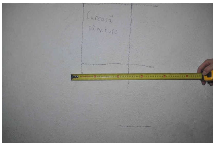
Foto nr. 21 – Carcasă de armătură sâmbure din ax 9
