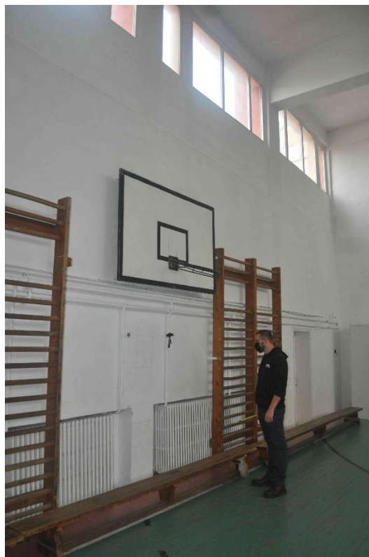
Foto nr. 1 – Aspect stâlp B/7 sondat nedistructiv
