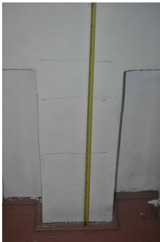
Foto nr. 7 – Dispunere etrieri pe zona critică a stâlpului B/3
