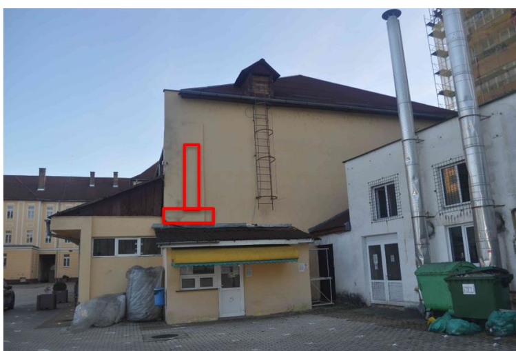
Fig. 14 – Scanări realizate pe frontonul din axul 1 în vederea confirmării existenței stâlpului B/1
