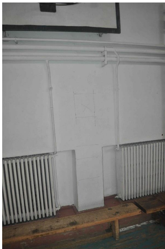
Foto nr. 5 – Aspect stâlp B/3 sondat nedistructiv
