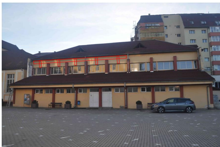
Fig. 23 – Scanări efectuate pe fațada din axul B în vederea determinării naturii materialului din care s-a realizat zona de peste stâlpii de beton armat
