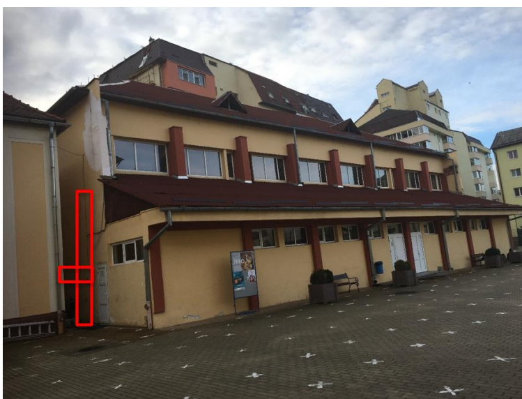
Fig. 15 – Scanări realizate pe frontonul din axul 9 în vederea confirmării existenței stâlpului B/9
