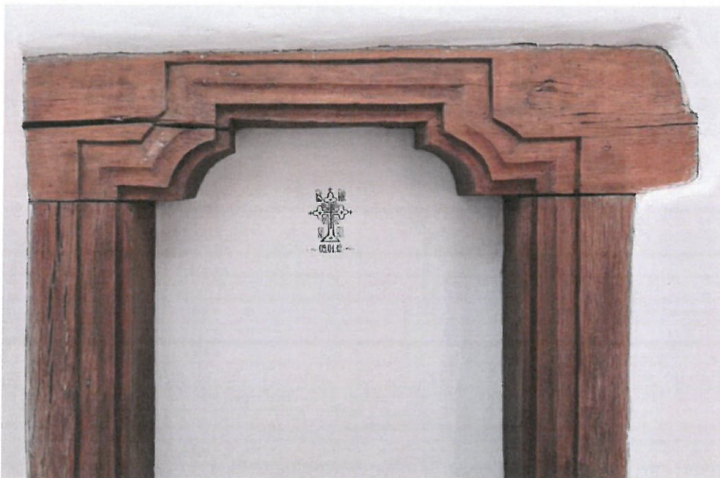
Fig. 61 Ancadrament gotic din lemn în camera E4.3. Detaliu
