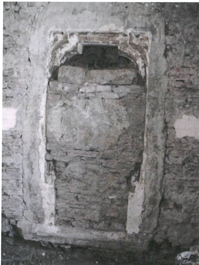
Fig. 74 Ancadrament gotic din camera E9
