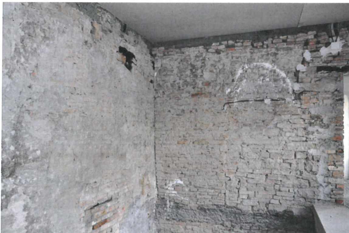
Fig. 64 Casa scării după decapare (2009). Sanda Salontai
