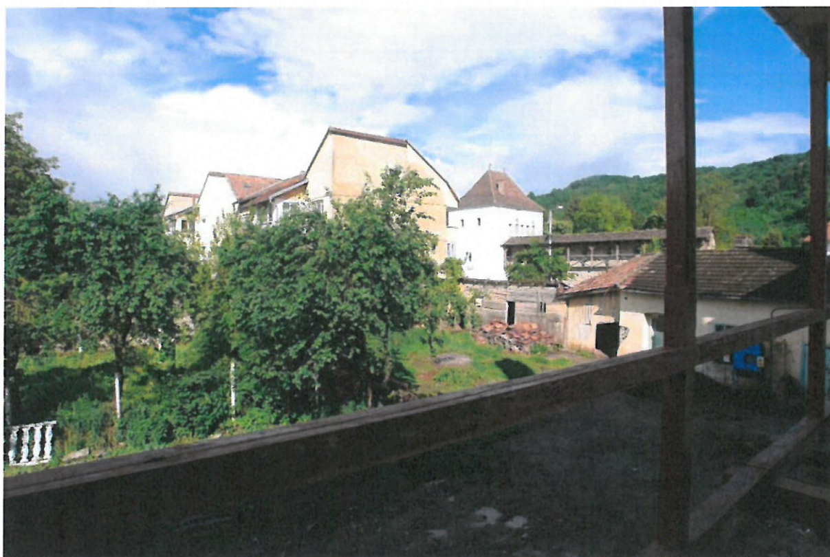
Fig. 29 Curtea și clădirile anexe înainte de demolare (2010). Virgil Pop
