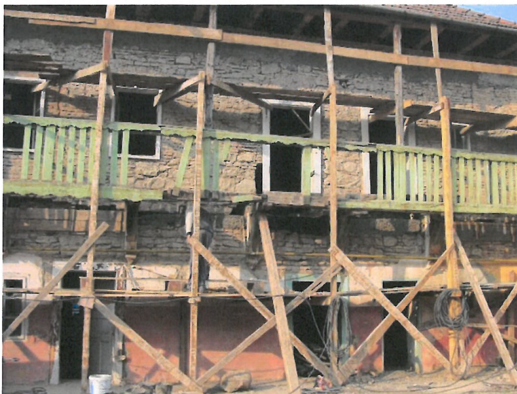
Fig. 28 Fațada de est cu paramentul decapat (2009)
