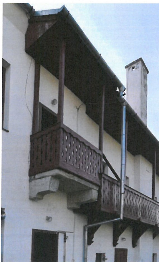
Fig. 31 Consolele de pe latura de est. Situația din 2022
