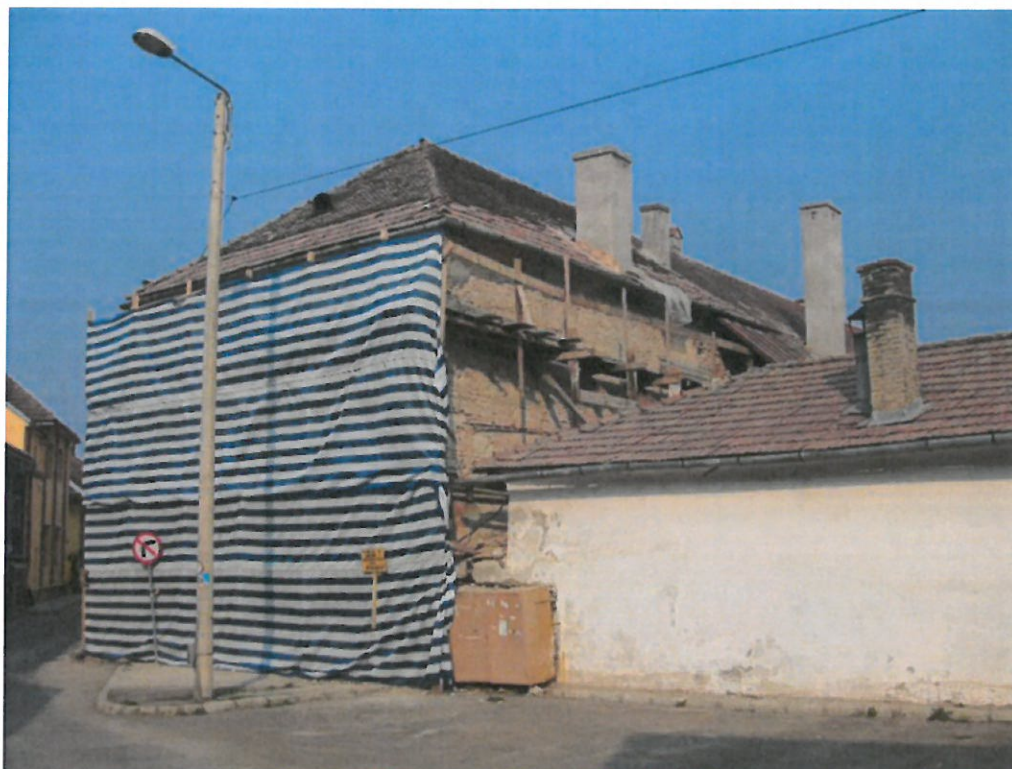
Fig. 26 Clădirea în timpul renovării din 2009-2011
