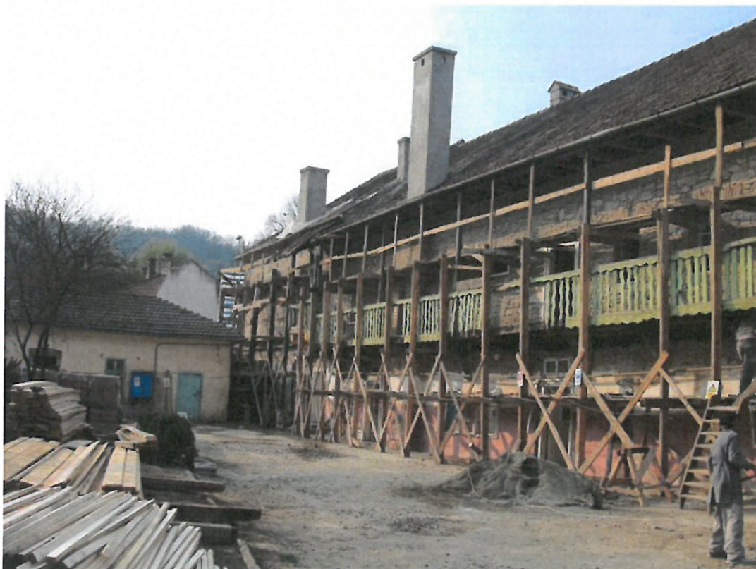
Fig. 27 Fațada de est cu paramentul decapat (2009)
