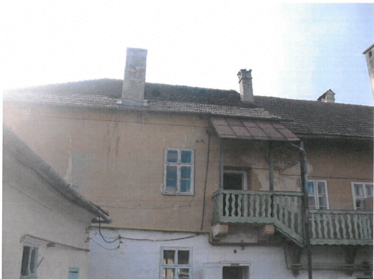
Fig. 25 Fațada de est înainte de renovarea din 2009
