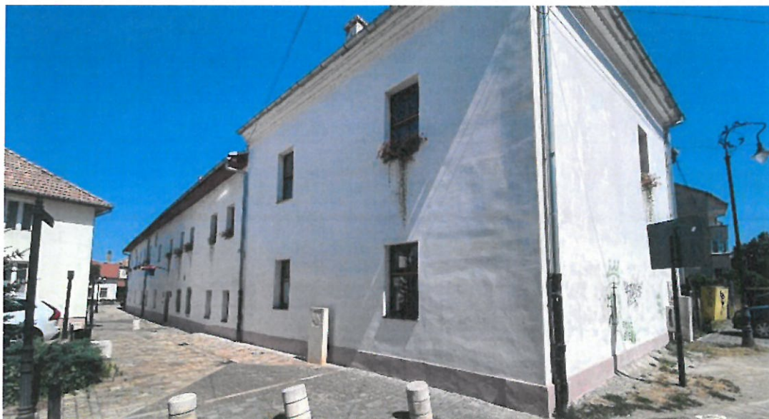
Fig. 15 Fațada de vest și sud
