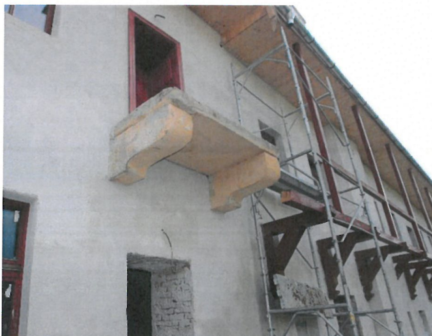
Fig. 30 Consolele de pe latura de est în timpul renovării. 2010. Virgil Pop
