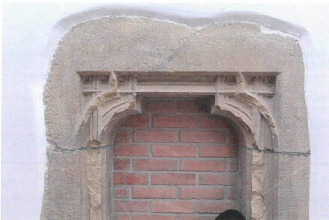
Fig. 75 Ancadrament gotic din camera E9. Detaliu
