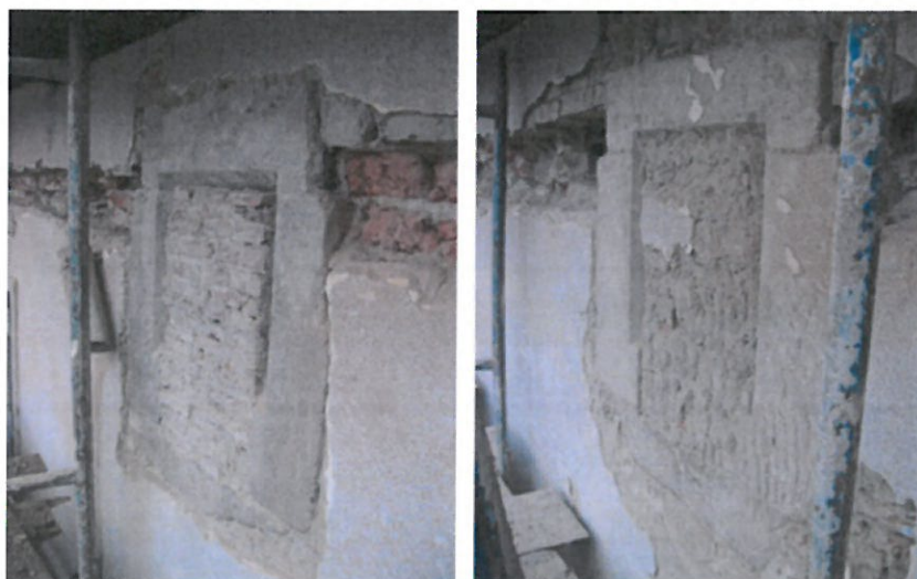
Fig. 17 Ferestrele gotice de la etaj în timpul dezvelirii
