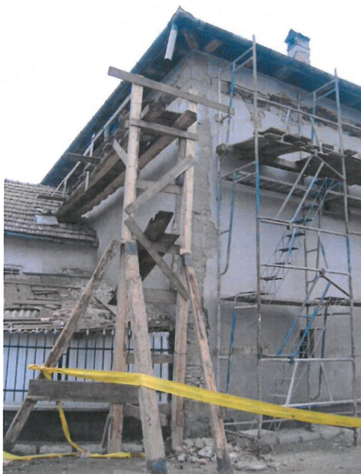
Fig. 14 Colțul de nord-vest în timpul decapării (2009)
