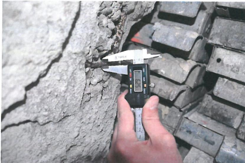
*Foto nr. 21 – Măsurare diametru etrier –  $\Phi 6$  mm*
