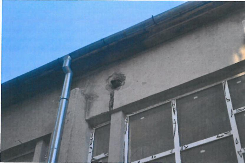
*Foto nr. 22 – Străpungere necorespunzătoare a grinzii din beton armat*
