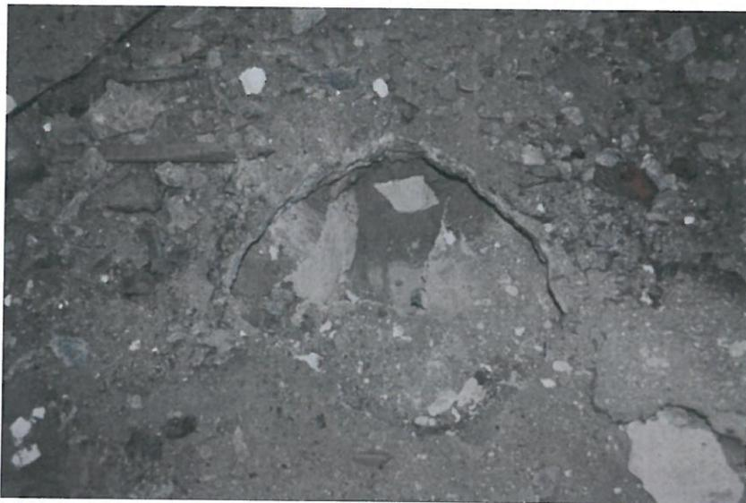
*Foto nr. 92 – Sondaj la partea superioară a planșeului peste vestiar*
