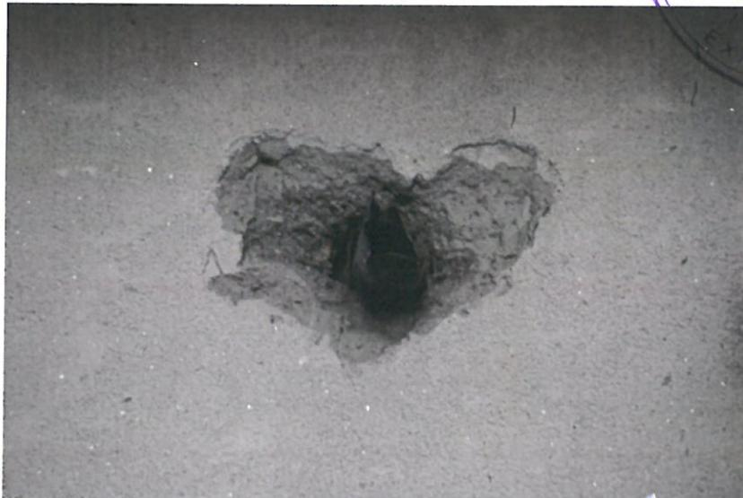
*Foto nr. 23 – Străpungere necorespunzătoare a grinzii din beton armat*
