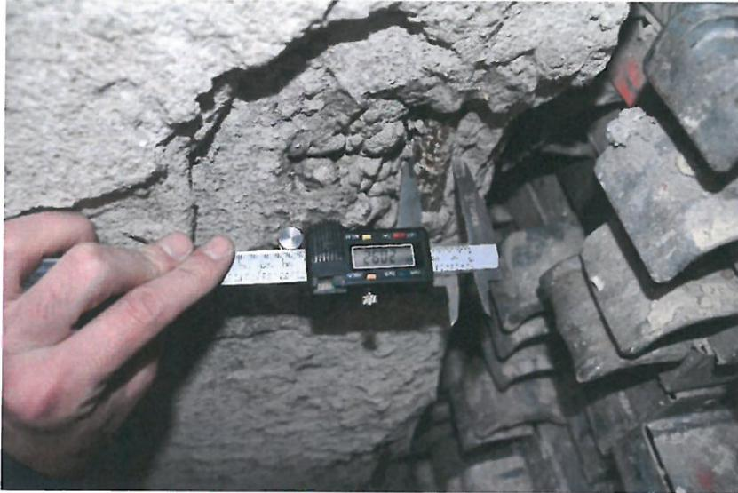
*Foto nr. 20 – Măsurare diametru bară de armătură longitudinală –  $\Phi 20$  mm*
