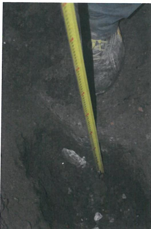
*Foto nr. 62 – Măsurare grosime talpă fundație în poziția B / 3 – 30 cm*
