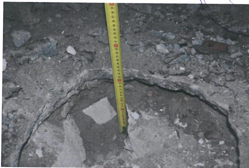
*Foto nr. 93 – Sondaj la partea superioară a planșeului peste vestiar*
