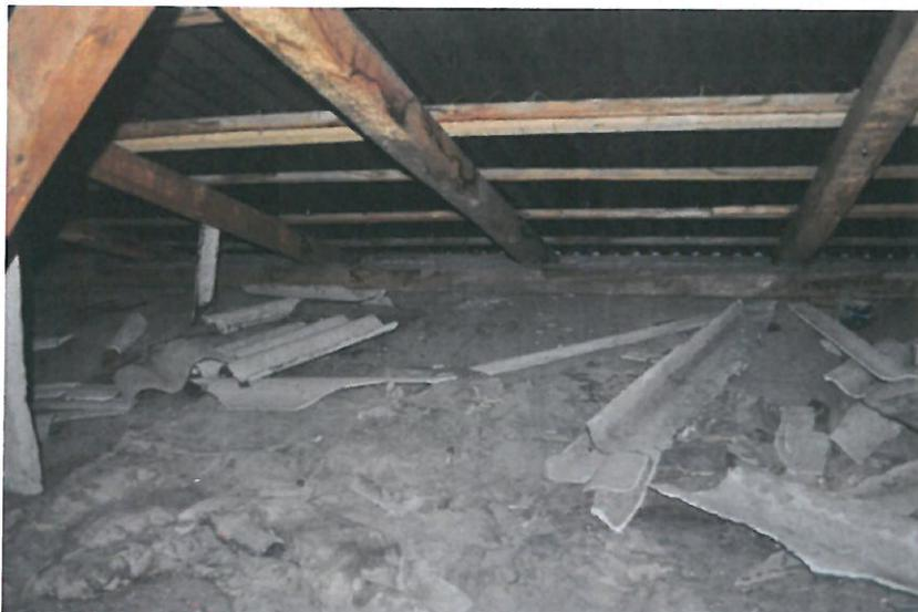
Foto nr. 54 – Îmbinări necorespunzătoare, strat suport învelitoare neconform
